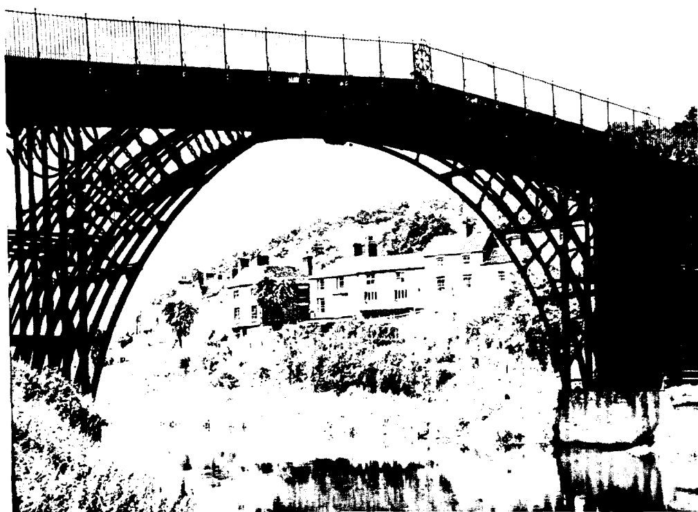
IRONBRIDGE. Le pont de Coalbrookdale.
